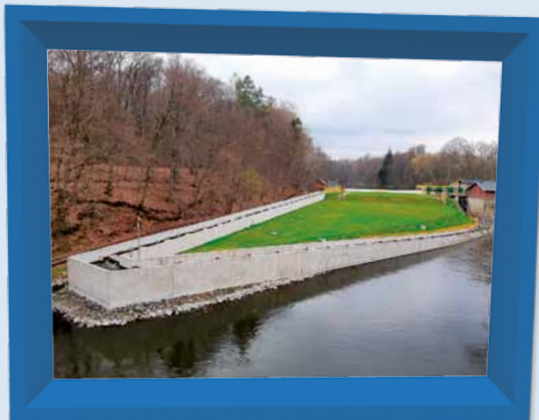
Przepławka dla ryb przy Elektrowni Wodnej „Kamienna”
